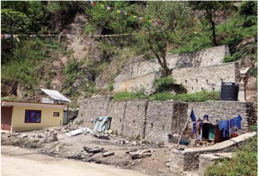
पहिरो जोखिम न्यूनीकरणका लागि स्थानीय तहले निर्माण गरेको संरचना, भोटेकोसी गाउँपालिका- २ फेमिलीकुना ।
